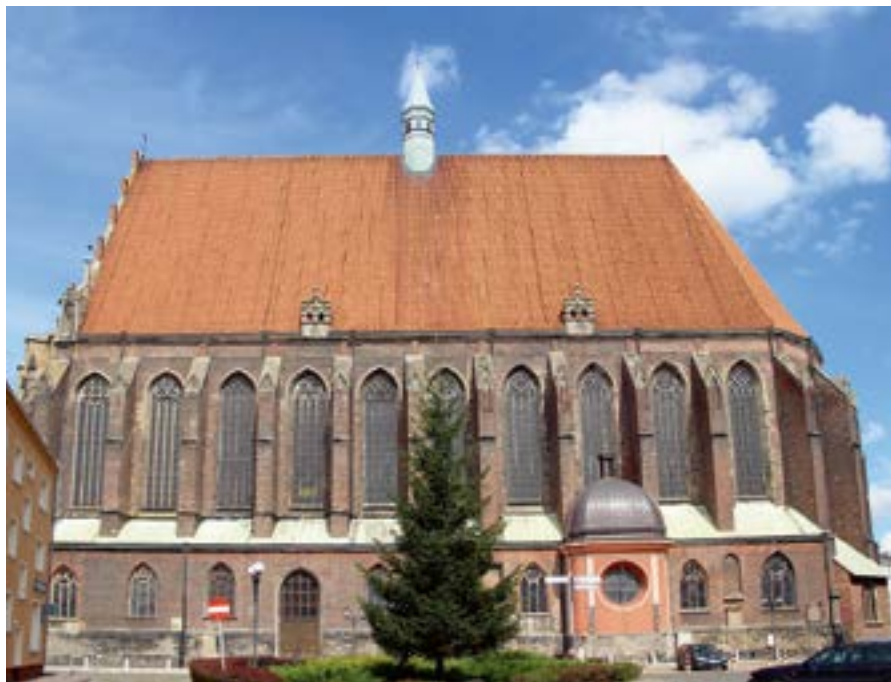
4 Nysa/Neiße, Pfarrkirche St. Jakobi, Blick von Süden
