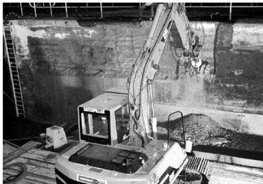
Abb. 3: Abbruch einer Kammerwand mittels Fräsen von einem Ponton aus (BAW 2009)
