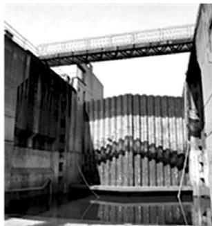
Abb. 1: Spundwandverschluss der als Sparkammer genutzten rechten Schleusenkammer Oberesslingen
