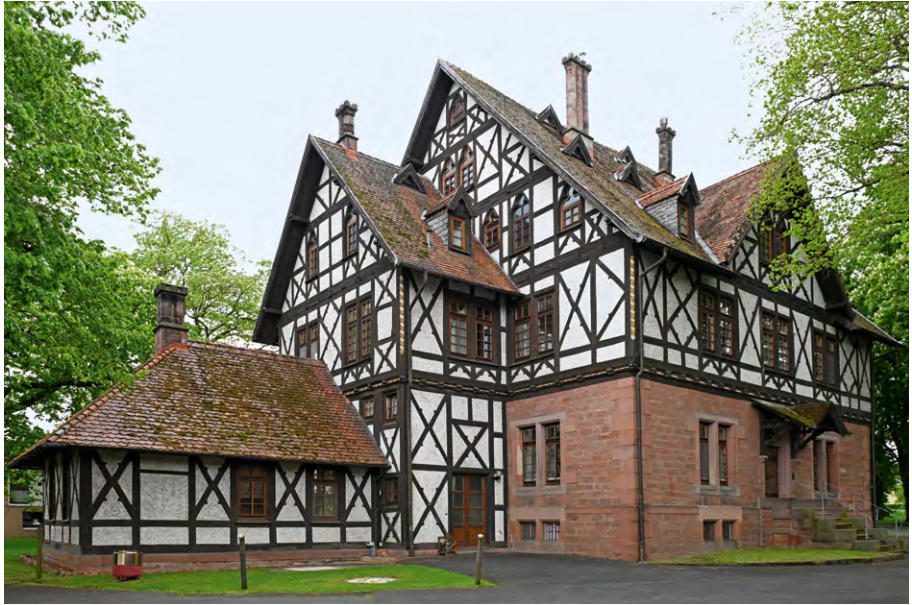
Abb. 3 Villa Wittgenstein (Berleburg) in Schlitz, Nordost-Fassade, Fotografie 2023
